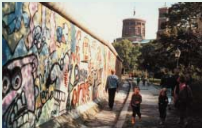
Intakte Mauer vor der Wende
